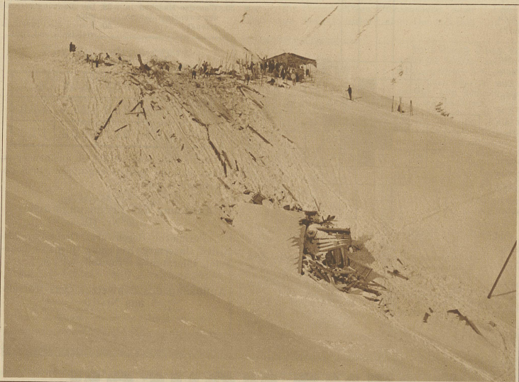
Anblick der Unglücksstelle während der Rettungsarbeiten. Im Vordergrund die Trümmer der vom Lawinendruck den Hang hinuntergeworlenen Hütte Phot. Funz, Davos
