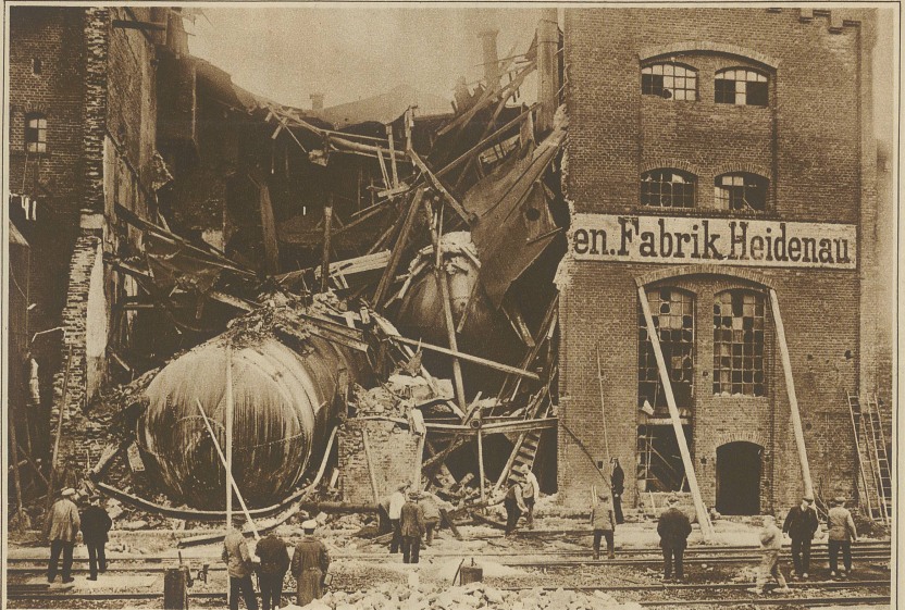
In Pirna explodierte während der Arbeitszeit ein Kessel der dortigen Sulfit-Zellulosefabrik, die durch die Explosion vollständig in Trümmer gelegt wurde. 11 Tote und zahlreiche Schwerverletzte fielen der Katastrophe zum Opfer
