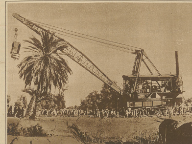
Ansicht eines Steinbagers, wie er zur Uferbefestigung der indischen Wägengeleise verwendet wird. Der Bagger verrichtet an einem Tage eine Arbeit, die sonst die Leistung von zwei Schreitern erforderte. Mit einem einzigen Hub vermag die Maschine 8 Tonnen Erdbreich auszuheben.
