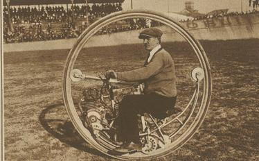
Nach längeren Versuchen ist es dem italienischen Ingenieur Dassi endlich gelungen, diese scheinbar unmögliche Fahrweise derart zu vereinfachen, daß es praktische Verwendung finden kann. Das Einsteigen hat einen Durchmesser von 175 cm und wird durch einen Viertaktmotor vorwärts bewegt.
