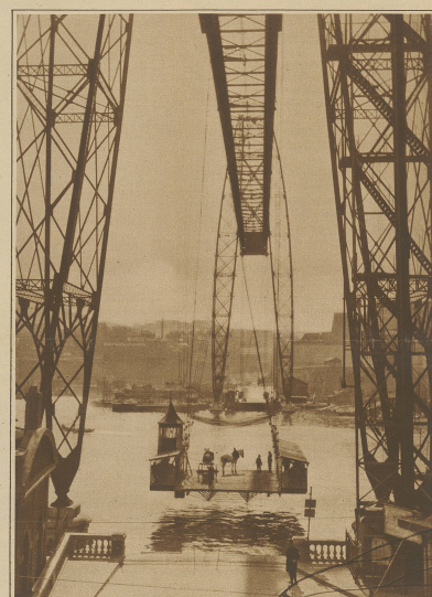
Die große transportierende Brücke im Hafenviertel von Marseille. Seitenansicht der Brücke mit der schwebenden Fähre
