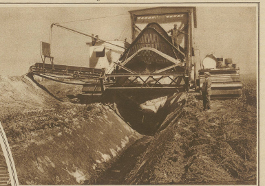
In Omaha (Nebraska U.S.A.) sind riesige Drainage-Maschinen an der Arbeit, die den dortigen verheerenden Regen bis zu einer Tiefe von 1 m untern und zu blühenden Feldern verwandelt.
