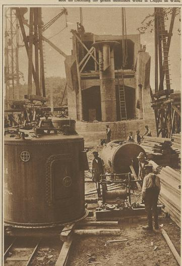
Die Versenkung des Mühlsteins bei Friedrichshagen, der über Wasser vollständig fertiggestellt und dann als Fußgänger-tunnel in den Fluß versenkt wurde
