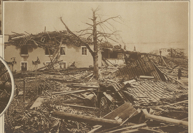
Das Trümmerfeld des Gehöftes Pierre Geiser in Chaux-d'Abel
