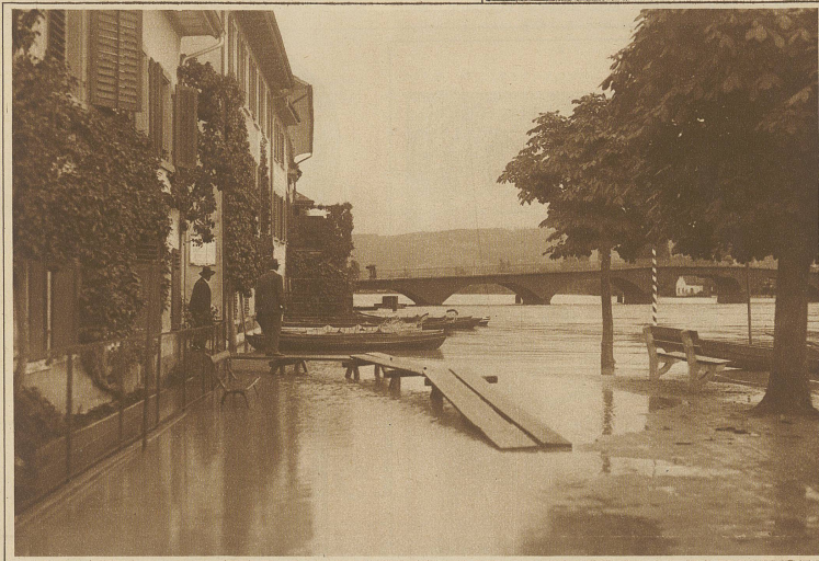
Die überschwemmte Uferpromenade in Stein a. Rh.
