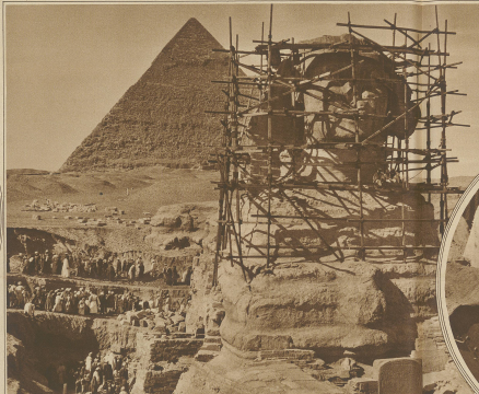
Die Sphinx wird vom Winterwande befreit. Restaurationsarbeiten an den altägyptischen Bauwerken
