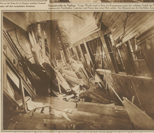
Inzwischen die vollständig zerstörten Postwagen, in welchen der nachfolgende Erdbebenstrom hinweggedrückt wurde.
