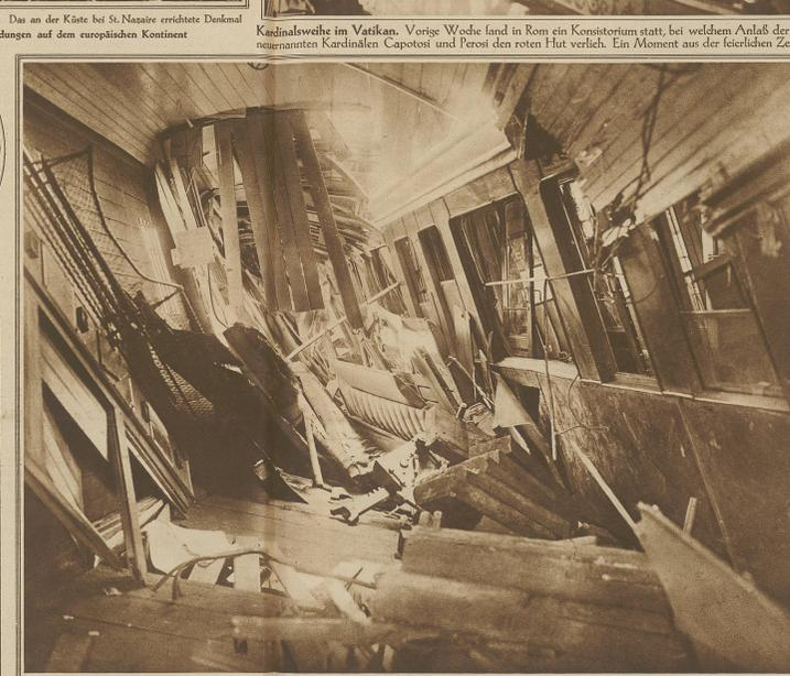
Innenansicht des vollständig zerstörten Postwagens, in welchen der nächstfolgende Erstklasswagen hineingeschoben wurde.
