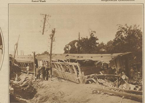
Blick auf die Unglücksstelle. Links oben in den Drahten hängt der Überrest einer Telegraphenstange, die durch die stürzenden Wagen weggerast wurde.
