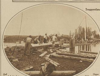
Auf dem Arbeitsplan für die Flugzeugwerke bei Albstadt am Bodensee sind die vier Arbeiter beschäftigt, die die vier Masten für die 125 Meter lange und 60 Meter breite Mastenbahn in den Boden versenken werden. Die Masten sind im Bild zu sehen.
