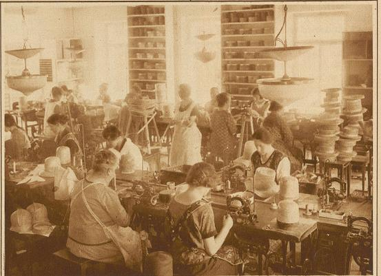
Nähen der Hüte mit der Maschine
