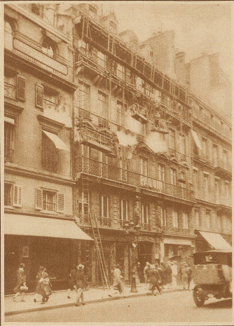
Die Fassadenreinigung durch Dampf ist eine der neuesten Erfindungen, die gegenwärtig in Paris mit gutem Erfolge ausprobiert wird. Der Dampf strömt unter Druck aus einem schmalen Schlitze und entfernt so allen Staub und Schmutz von der Oberfläche der Steine
