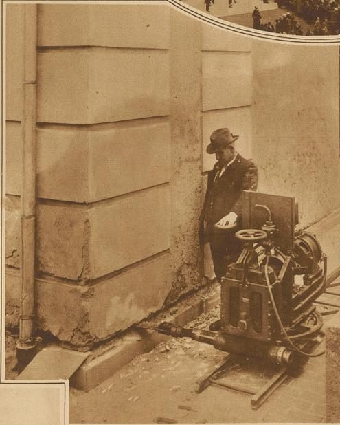
Die neueste Errungenschaft auf dem Gebiete der Technik ist die von einem Münchner Baumeister erfundene elektrische Mäuersäge, die dazu dient, Wasser ziehendes, durchfeuchtetes Mauerwerk zu ebener Erde durchzuschneiden, so daß in die Schnittfuge eine Isoliermasse eingegossen werden kann. Auf diese Weise können Häuser, ohne Belästigung der Bewohner, vor dem Hausschwamm gesichert werden
