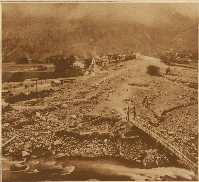
Ringgenberg, wie es heute aussieht. Im Vordergrund die von den Sappeuren erbaute neue Brücke Phot. Lang
