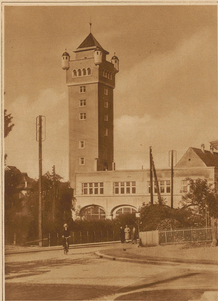
Ein originelles Fabrikamin, das inmitten des Städtchens Arbon errichtet wurde und eine Wohnung, eine Aussichtsterrasse, ein Hochdruck-Wasserreservoir und einen Lift enthält Phot. Burkhardt
