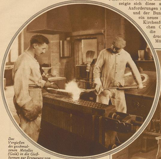
Das Vergießen des geschmolzenen Metalles (Gold) in die Gießformen zur Erzeugung von auswalzbaren Schienen (Zainen)
