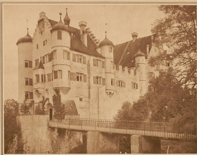
Ansicht der Ostfront und der Zugangsbrücke
