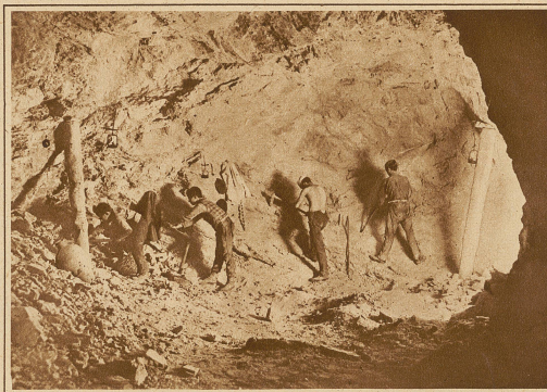
Vorbereitungen für eine Sprengung
