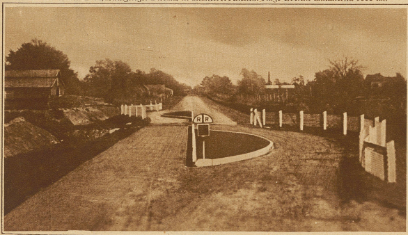
Ein praktischer Schuss für Automobilisten an Bahnübergängen. Die Stadt Collondale in Florida hat zur Vermeidung von Unfällen an Bahnübergängen eine neuartige Anlage geschaffen. In der Mitte der Landstraße ist zu beiden Seiten der Geleise eine halbkreisförmige Raseninsel angelegt, so daß der Fahrer nicht im schnellsten Tempo geradeaus fahren kann, sondern sein ganzes Augenmerk auf dieses Hindernis legen muß
