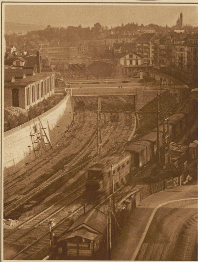
Unterführungsbauten beim neuen Bahnhof Wiedikon, der als Reiterbahnhof über die Geleiseanlagen gebaut wurde
