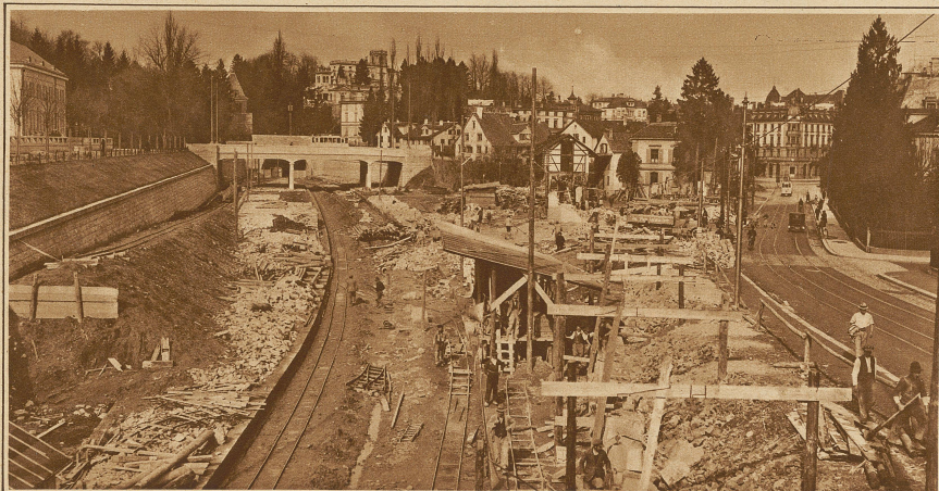
Die Arbeiten für die Anlage der neuen Station Engen. Rechts die Seestraße, längs welcher einige Häuser niedergelegt werden mußten, um Platz für den Neubau zu schaffen. Links hinten die Ueberführung der Bederstraße, dahinter der neue Ulmerstunnel nach der Station Wiedikon
