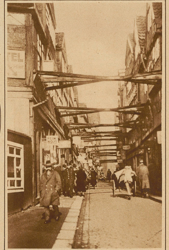
Ein eigenartiges Straßenbild. Eine Straße in Alt-Hamburg, deren Häuser durch Verstreubungen gegen Einsturz geschützt werden
