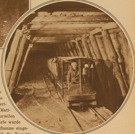
Stollengang mit elektrischer Lokomotive
