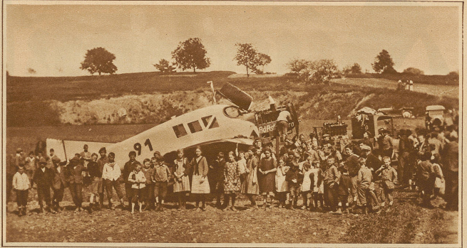
Das Postflugzeug des Kurses Stuttgart-Zürich war infolge Kurbelwellenbrüches gezwungen, zwischen Diessenhofen und Schlatt eine Notlandung vorzunehmen, die ohne den geringsten Unfall glatt verlief. Nach Einbau eines von Dübendorf gebrachten Ersatzmotors konnte der Apparat am andern Tage den Flug wieder fortsetzen. Phot. Romberg
