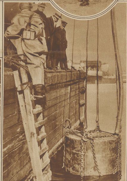
Um den nächsten U-Bootkatastrophen nicht wieder gänzlich hilflos gegenüberzustehen, hat man in Amerika eifrig Versuche gemacht, die zunächst dazu dienen sollen, die Taucher lange auf dem Meeresgrund zu halten und die Rettungsarbeiten so vor jeder Unterbrechung zu schützen. Zu diesem Zwecke arbeitet man mit einem riesigen zylindrischen Tank, in dem die Taucher auf den Meeresgrund hinabgelassen werden. Durch Zuleitungsrohre können ihnen während der Arbeit Luft und Nahrungsmittel zugeführt werden.
