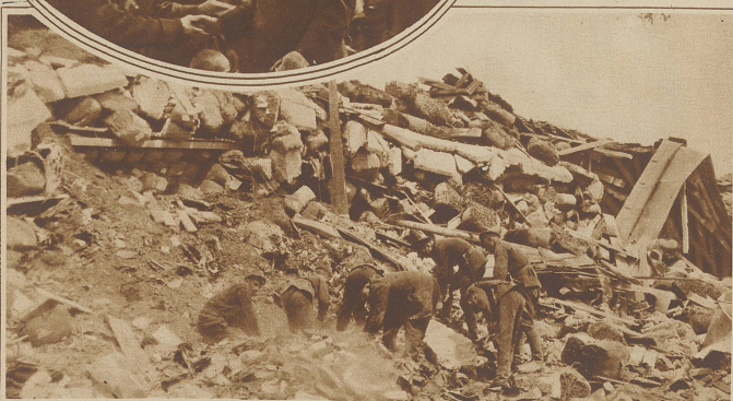
Der Trümmerhaufen der Volksbank in Tschirpan
