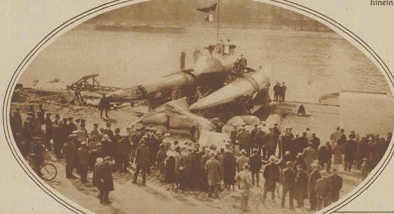
Der Ozeano-Glasseur ist das neueste Vehikel, mit welchem die Überquerung des Ozeans im nächsten Monat versucht werden soll. Wie das Bild zeigt, handelt es sich um ein Cliftboot, das außer mit Schrauben auch mit Luftpropellern angetrieben wird. Man rechnet mit einer durchschnittlichen Geschwindigkeit von gegen 100 km.
