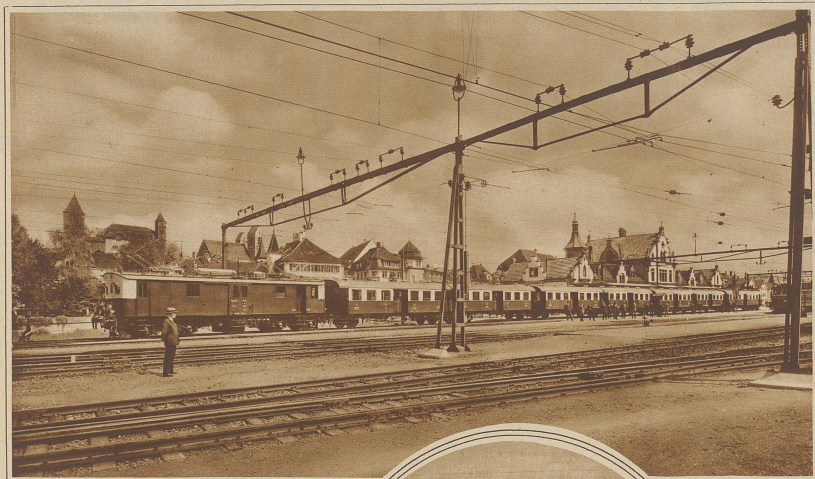
Die neuen Vorentzüge der Schweiz Bundesbahnen, die versuchsweise vorerst auf den Strecken Basel-Olten und Zürich-Rapperswil verkehren werden. Der Zug besteht aus je einem Motorwagen und einem Zugführungswagen, sowie aus drei Doppelwagen, die kurz gekuppelt und durch Faltenbalg und bequemem Übergang verbunden sind. Jedes Rangieren des Motorwagens fällt weg, da der Motorwagen auch von dem am andern Ende sich befindenden Führerwagen aus gesteuert werden kann, so daß also nur der Führer die Kabine zu wechseln hat. Alle Türen werden vom Führerstand aus automatisch auf einen Schlag geschlossen, sobald sich der Zug in Bewegung gesetzt hat. — Das Rollmaterial des ganzen Zuges wurde von der Schweiz Waggonfabrik Schlieren, die elektr. Ausrüstung von Sicherern in Gené geliefert.
