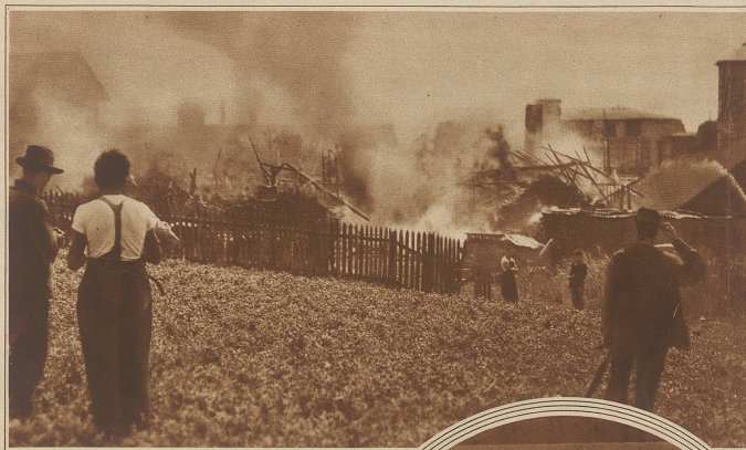
Auf der Brandstätte nach dem Zusammensturz der verschö- denen Gebäude. Das links im Bilde ersichtliche Hauptgebäude wurde später von den Flammen ebenfalls ergriffen Phot. Wild
