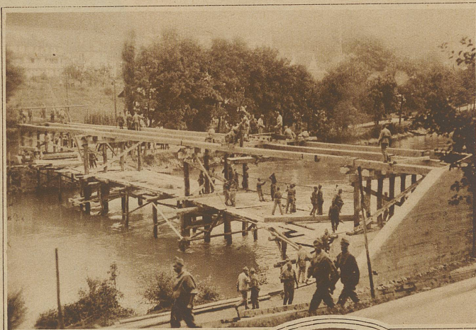
Stand der Bauarbeiten am 4. Tage
