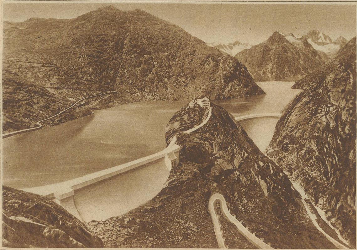
Zum Bau der 380 m langen Gelmersperre, die den Spiegel des Gelmersees um 30 m erhöhen und damit dreizehn Millionen Kubikmeter Stauraum schaffen wird, sind die Geleise der Materialtransportbahn auf die Eisengerüste gelegt worden, die mit einbetoniert werden
