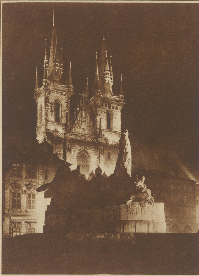
Das Denkmal des tschechischen Reformators Hus
