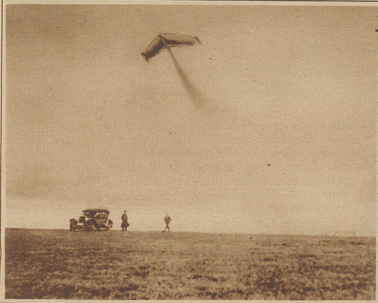
Die ersten Versuche mit dem Raketenflugzeug sind auf der Wasserkuppe in Deutschland gemacht worden. Das obere Bild zeigt den Versuchsflug des Modells, das im Bild rechts auf der Gleitbahn ersichtlich ist
