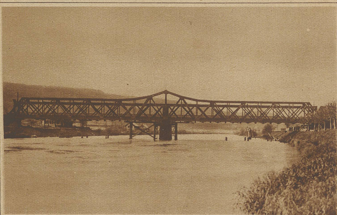
Auswechseln der Eisenbahnbrücke über die Aare bei Brugg. Die neue Brücke wurde direkt neben der alten montiert und in der Nacht vom 17. auf den 18. November an die Stelle der alten geschoben
