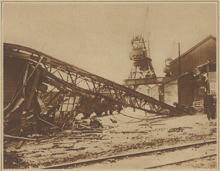
Rechts nebenstehend: Anlässlich eines Sturmes über England erlebten die Gäste eines Hafenrestaurants in Southampton eine unangenehme Überraschung, als einer der Riesenkräne durch die Gewalt des Sturmes umgeworfen wurde und dabei das Dach des Lokals durchschlug. Zwei Gäste wurden verletzt
