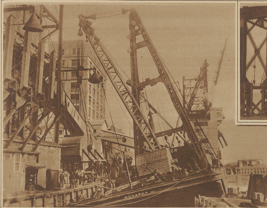
Der größte Schwimmkran ist im Hafen von New York zu sehen, wo damit kürzlich zwei Generatoren im Gewicht von je 113 000 kg ausgeladen wurden. Im Bilde hängt eine der Kisten schon über dem Kai; der Schwimmkran neigt infolge des großen Gewichts stark zur Seite
