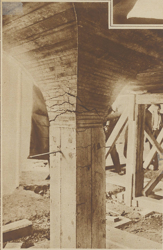
Durch die Ueberlastung erzeugte Risse im Betonpfeiler der Probekonstruktion
