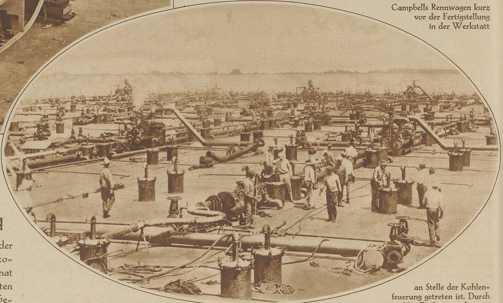
Eine gewaltige schwimmende Tankanlage, wie man sie jetzt in den Meerhäfen baut, seit auf den Ozeanriesen die Oel-
