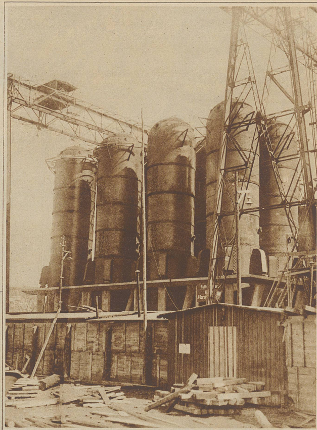
Eine riesige Dampfspeicheranlage ist vom Charlottenburger Elektrizitätswerk errichtet worden. Jeder Kessel ist 23 Meter hoch und hat 4,5 Meter Durchmesser. In diesen Riesentuben wird der am Tage nicht benötigte Dampf aufgespeichert, mit dem dann am Abend noch weitere 40 000 Kilowattstunden Strom erzeugt werden können
