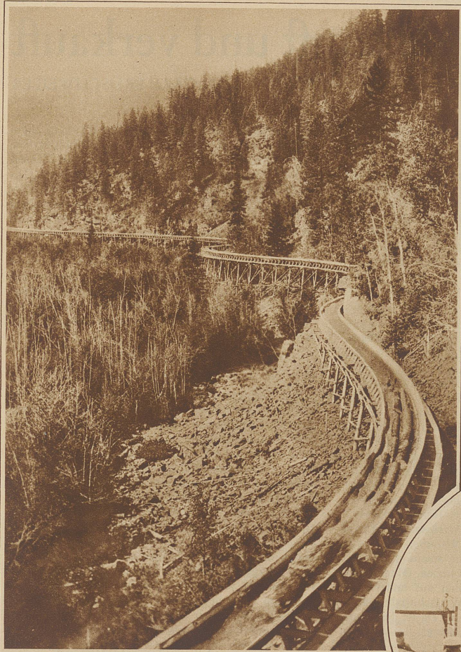
Eigenartige Holztransportbahnen werden in den riesigen Wäldern von British Columbia gebaut. Da es sich in diesen unwegsamen Gebieten Kanadas nicht lohnen würde, Straßen oder gar eine Eisenbahn anzulegen, verfiel man auf die Idee, große Schwemmkanäle zu errichten, durch welche die in den oberen Regionen gefällten Baumstämme viele Kilometer weit zur Verarbeitung in die Papierfabriken transportiert werden
