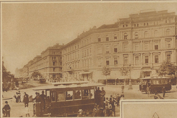
Die erste elektrische Straßenbahn mit unterirdischer Stromzuführung wurde vor 40 Jahren in Budapest in Betrieb genommen. Die Fahrlleitung befindet sich im Schlitzkanal der Schienen.
