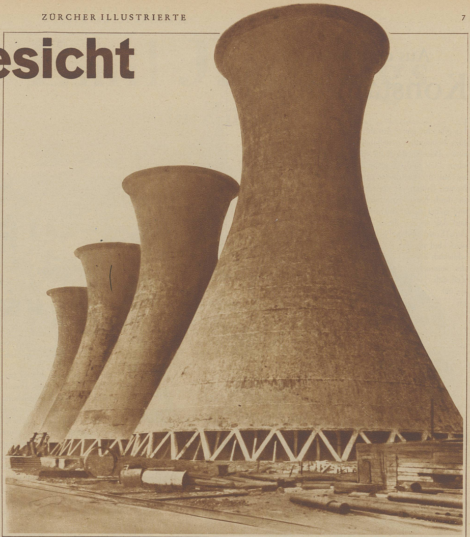
Kühltürme der Staatsgrube «Emma»
