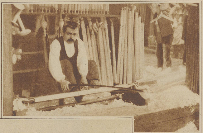
Drechsler in seiner Werkstatt, die nach der Straße offen ist. Er arbeitet in primitivster Weise, indem er die Stange mittels eines Bogens dreht und das Messer mit dem Fuß andrückt
