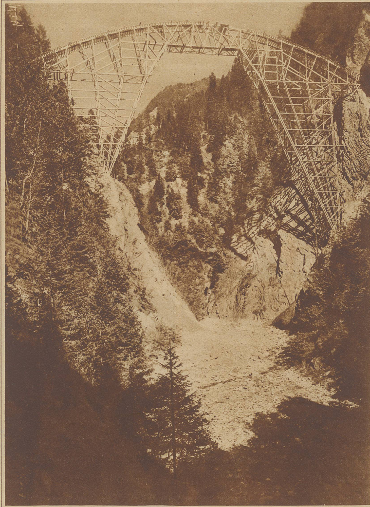
Das Gerüst der Salginabrücke, die Schiers mit dem Bergdörfchen Schuders verbindet. Sie ist ein Beweis dafür, wie man sich in Graubünden bemüht, der Entwölkung der Gebirgstäler entgegenzuarbeiten. Erbauerin ist die bekannte bündnerische Brückenbaufirma Coray
