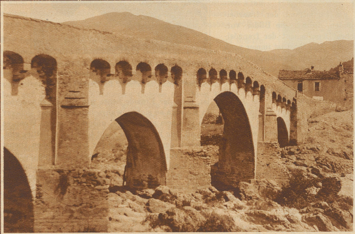
Ponte Leccia, die schönste Brücke Korsikas
