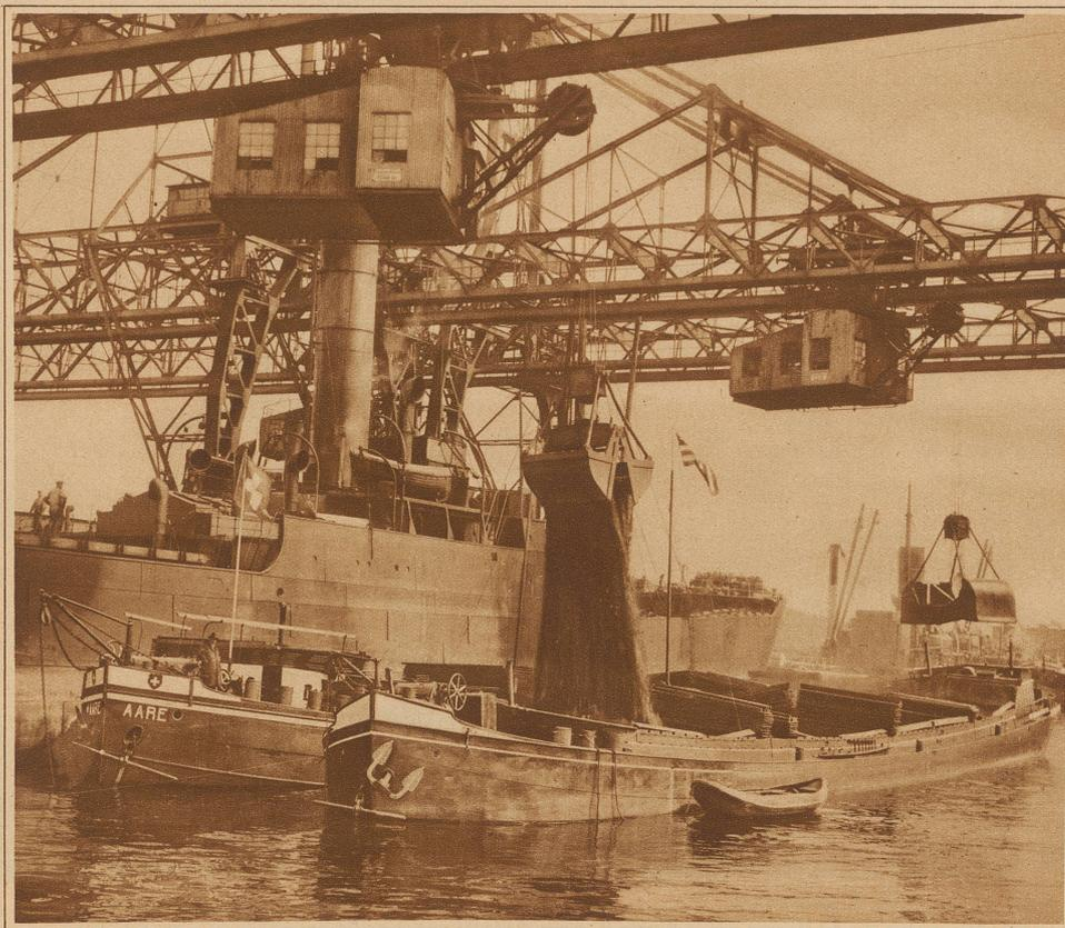
Bild links: Rotterdam. Verladen englischer Kohle von Meerdampfer direkt in Schwizerschiffe für den Verband Schweizer Gaswerke
