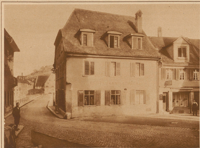
Das gefährliche Straßenknie an der Rheinbrücke Feuerthalen-Schaffhausen
