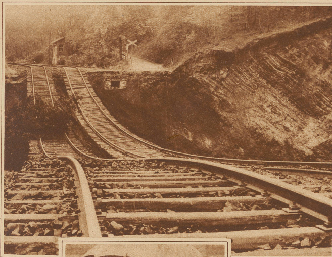
Bergwerkeinsturz bei Vienenburg. Infolge der andauernden Regengüsse der letzten Woche erfolgte in den staatlichen Kalibergwerken Vienenburg (Deutschland) ein Wassereinbruch, der zur Folge hatte, daß das ganze Werk einstürzte. An der Oberfläche bildeten sich bis zu 100 m tiefe kraterähnliche Löcher. — Das Bild zeigt die durch den Einsturz frei hängenden Eisenbahngleise
