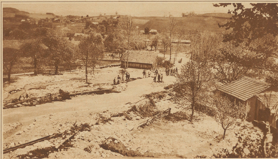
Auch das Dörfchen Blumenstein im obern Gurbetal wurde schwer heimgesucht. Das Geschiebe lagert stellenweise metertief über den vernichteten Kulturen (Phot. Sollberger)
