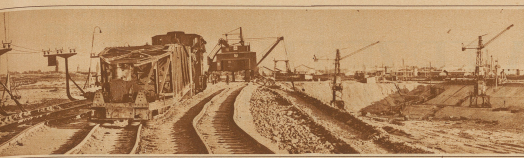
Links oben: Blick auf die Baustelle, wo die 6 Turbinen zu je 33 000 P.S. ein-gefaßt werden. Das Eisengerüst dient als Betonvermittlungs-ge
