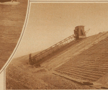
An dieser Stelle hat der Kanal eine Tiefe von 12 m und eine Breite von 150 m. Die Stauesse wurde mit einer Spreitmaschine leicht betont
