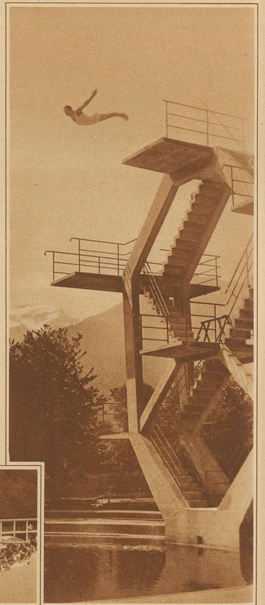
Der neuzeitliche Sprungturm aus armiertem Beton. Im Hintergrund die «Schwalmern»
